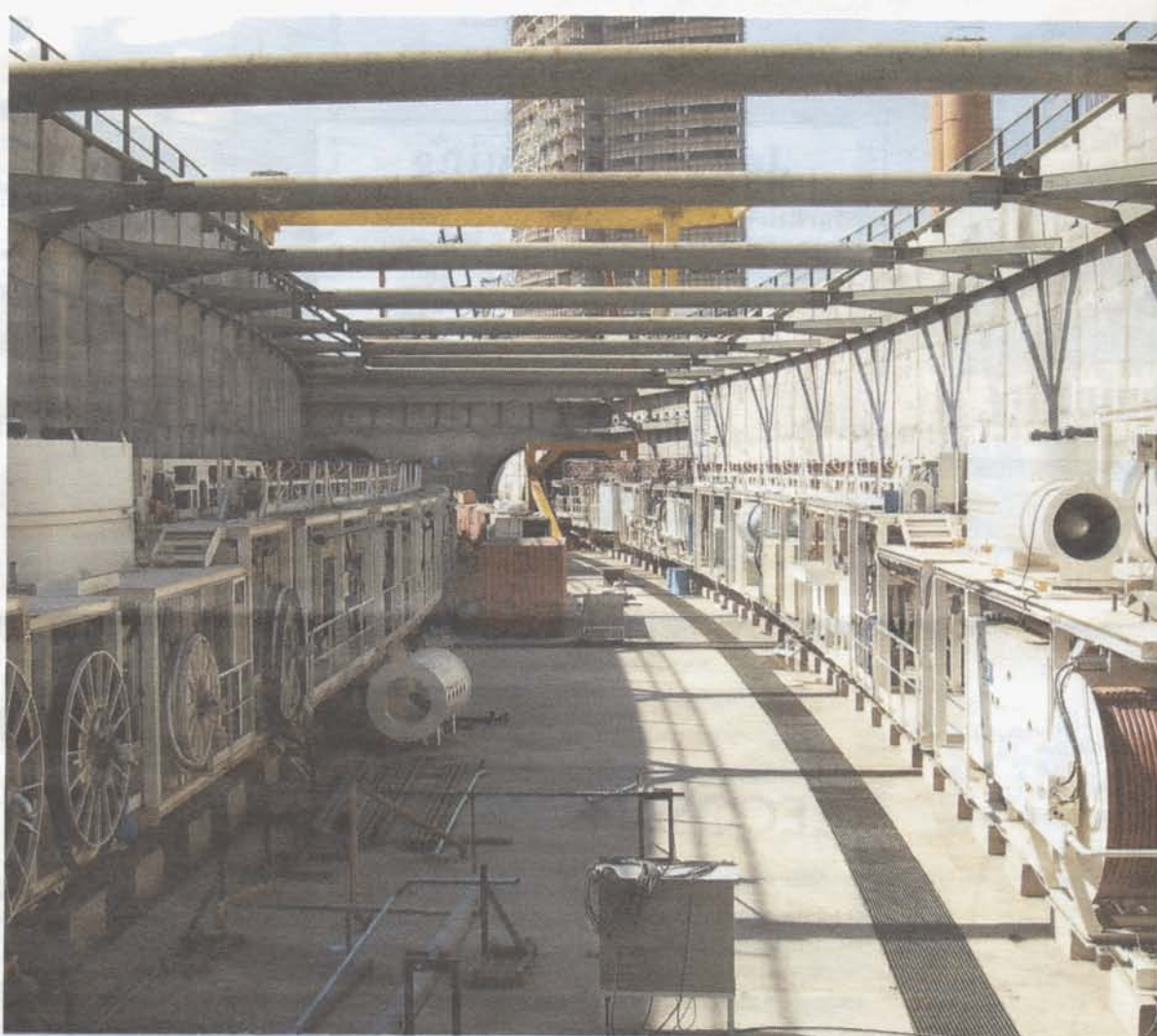
Startschacht van de tunnelboormachine van Tabriz waarvoor Arthe de detailengineering verzorgde. Bron: Arthe
