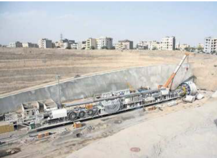
Tunnelbouw in Iran.
